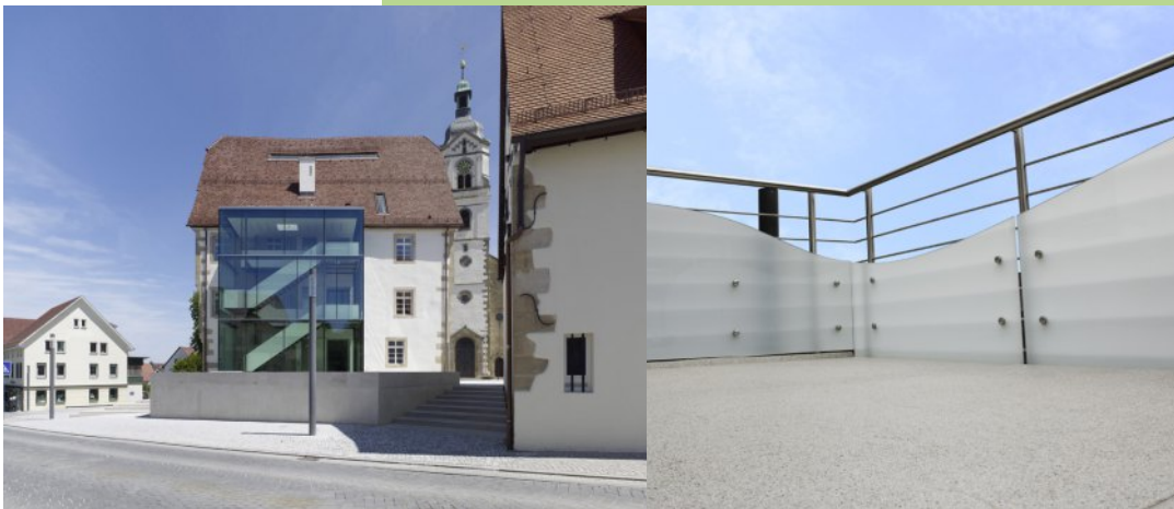
Verglastes Treppenhaus, oberes Schloss Neuhausen. Schröder Stahl & Metallbau GmbH
