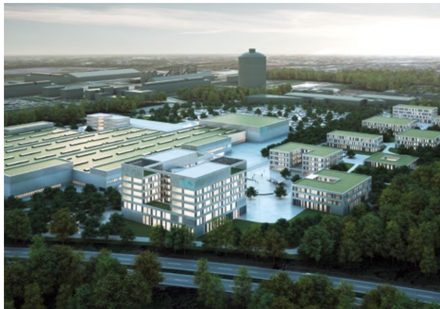
Neubau Unternehmenshauptquartier Wilo Campus in Dortmund
